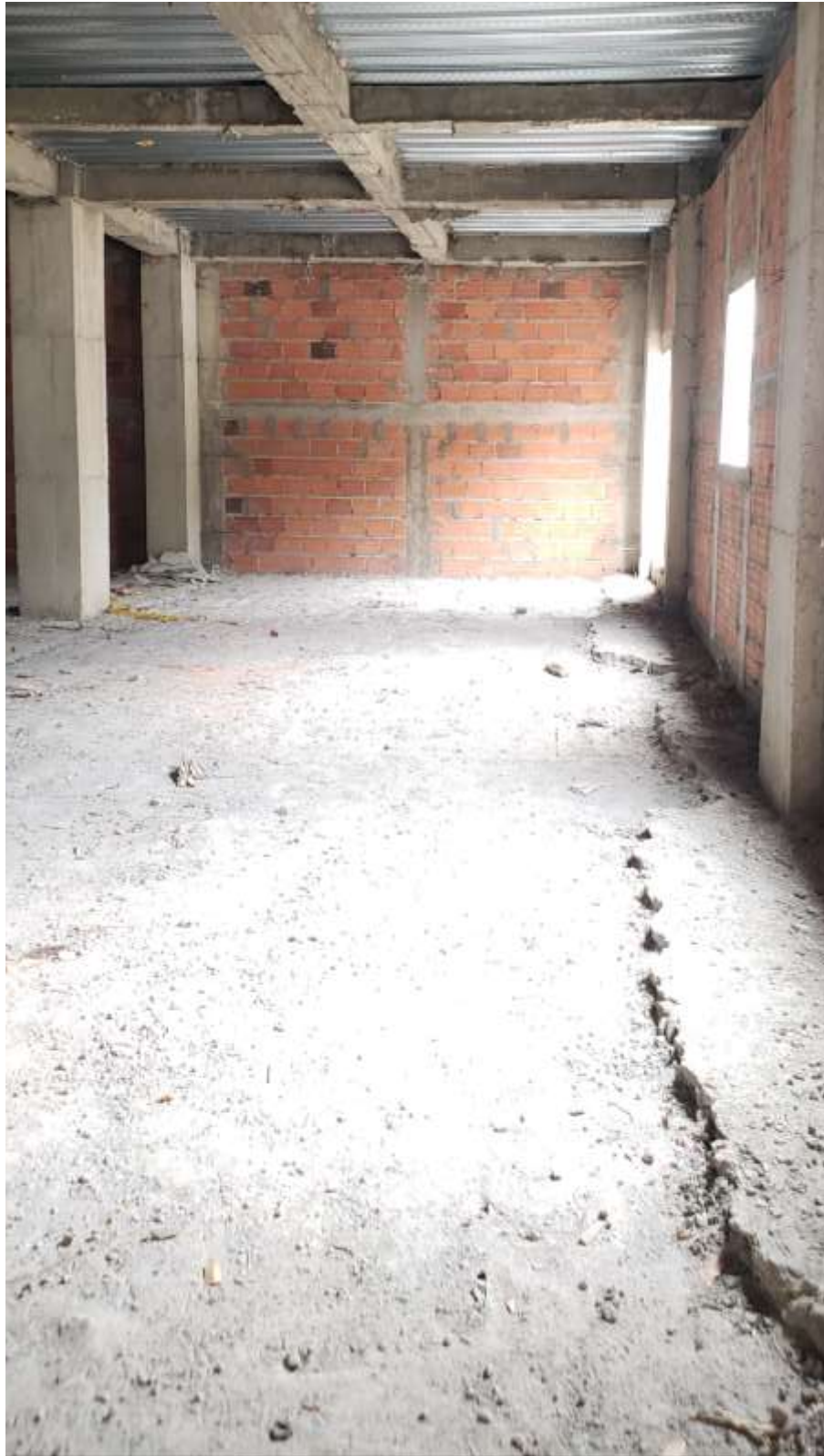
Área pasillo de limpieza y circulación
