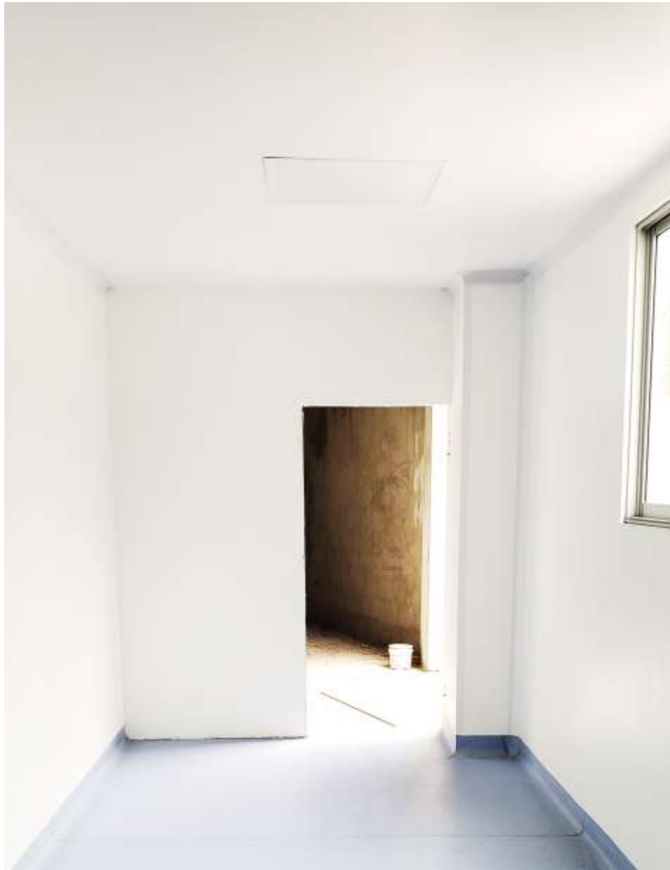
Pasillo de limpieza. Conexión área terminada con área a intervenir
