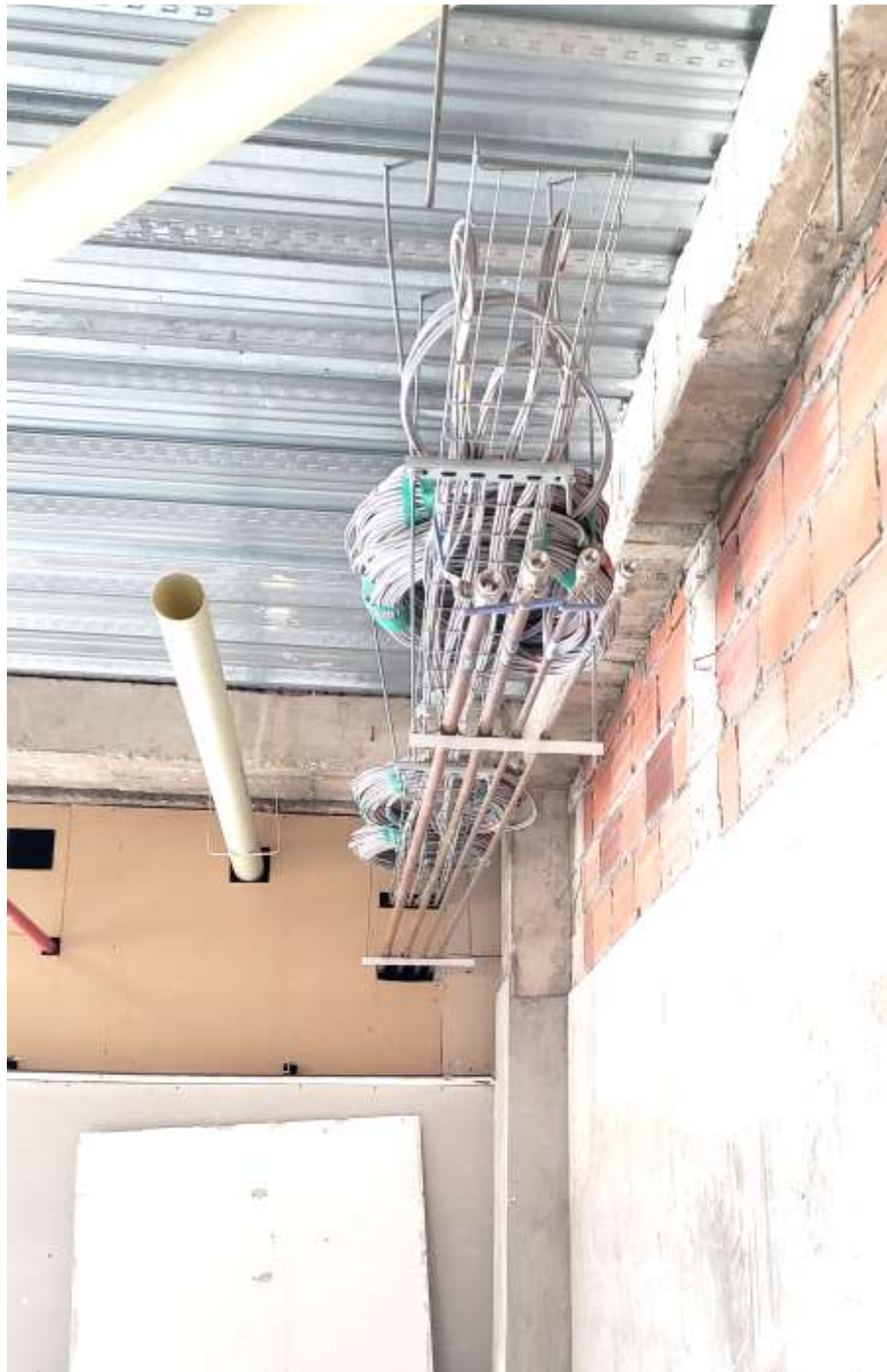
Redes de voz y datos y gases medicinales
